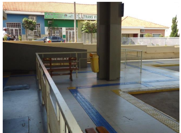
Figura 72 – Cesto na área de embarque Fonte: EngFlora Engenharia e Meio Amb. (2014)
