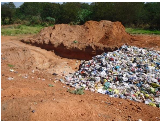
Figura 37 – Aterro em vala Fonte: EngFlora Engenharia e Meio Amb. (2014)
