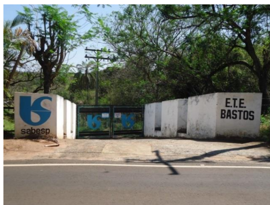
Figura 74 – Estação de Tratamento de Esgoto de Bastos – ETE Fonte: EngFlora Engenharia e Meio Ambiente (2014)
