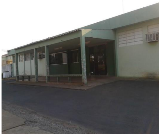
Figura 51 – Hospital de Bastos Fonte: EngFlora Engenharia e Meio Amb. (2014)
