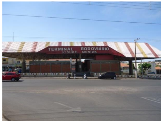
Figura 70 – Terminal Rodoviário de Bastos Fonte: EngFlora Engenharia e Meio Ambiente (2014)
