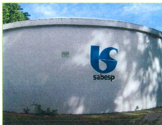
Foto 06 - Reservatório apoiados de 750 m 3
