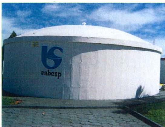
Foto 07 - Reservatório apoiados de 250 m 3
