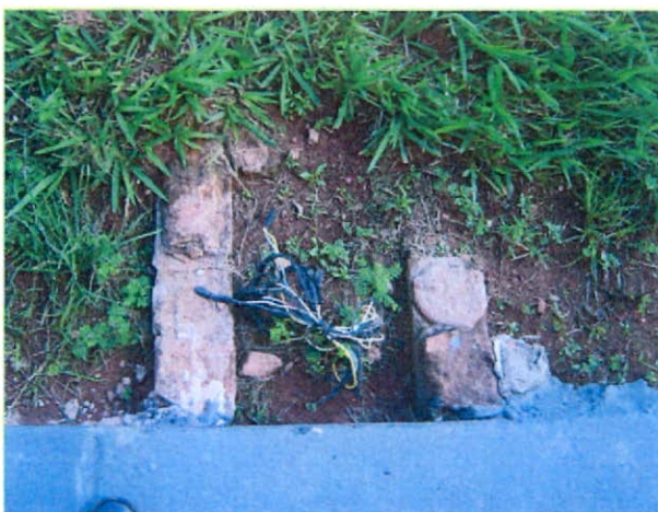
Foto 10 - Fiação desprotegidas
