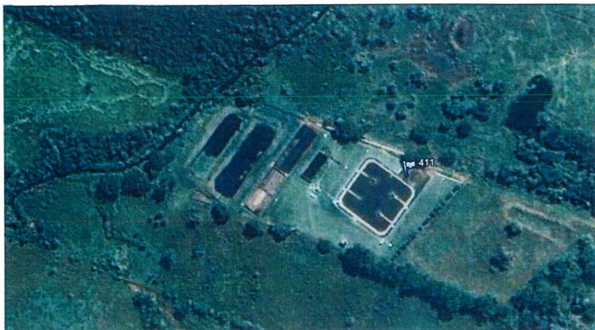
Imagem 05 - Localização da ETE
