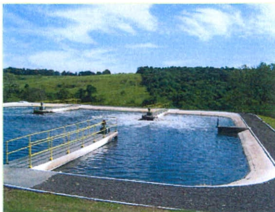
Foto 17 - Tanque de aeração prolongada
