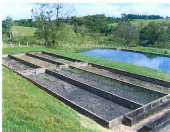
Foto 19 – Leitos de Secagem de Lodo e lagoa de maturação.
