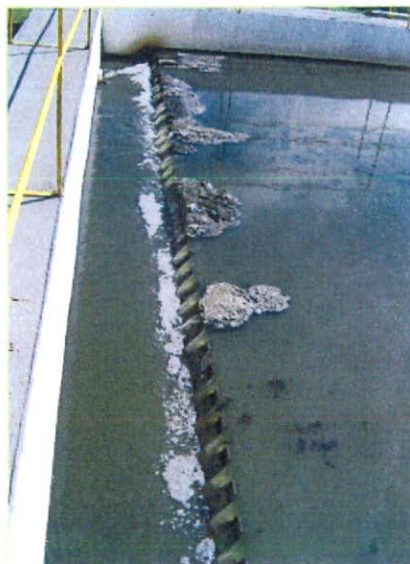
Foto 20 : Sobrenadantes no vertedouro
