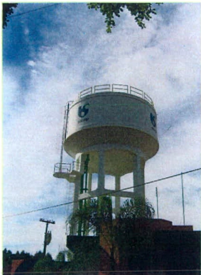
Foto 05 - Reservatório elevado de 280 m 3
