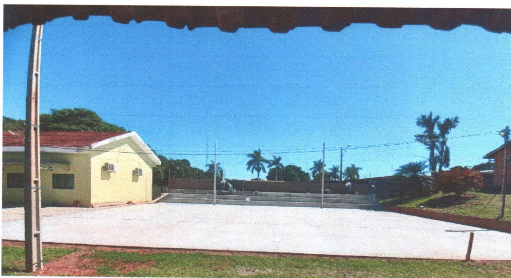
Fotos 14, 15 e 16: Revestimento da arquibancada
