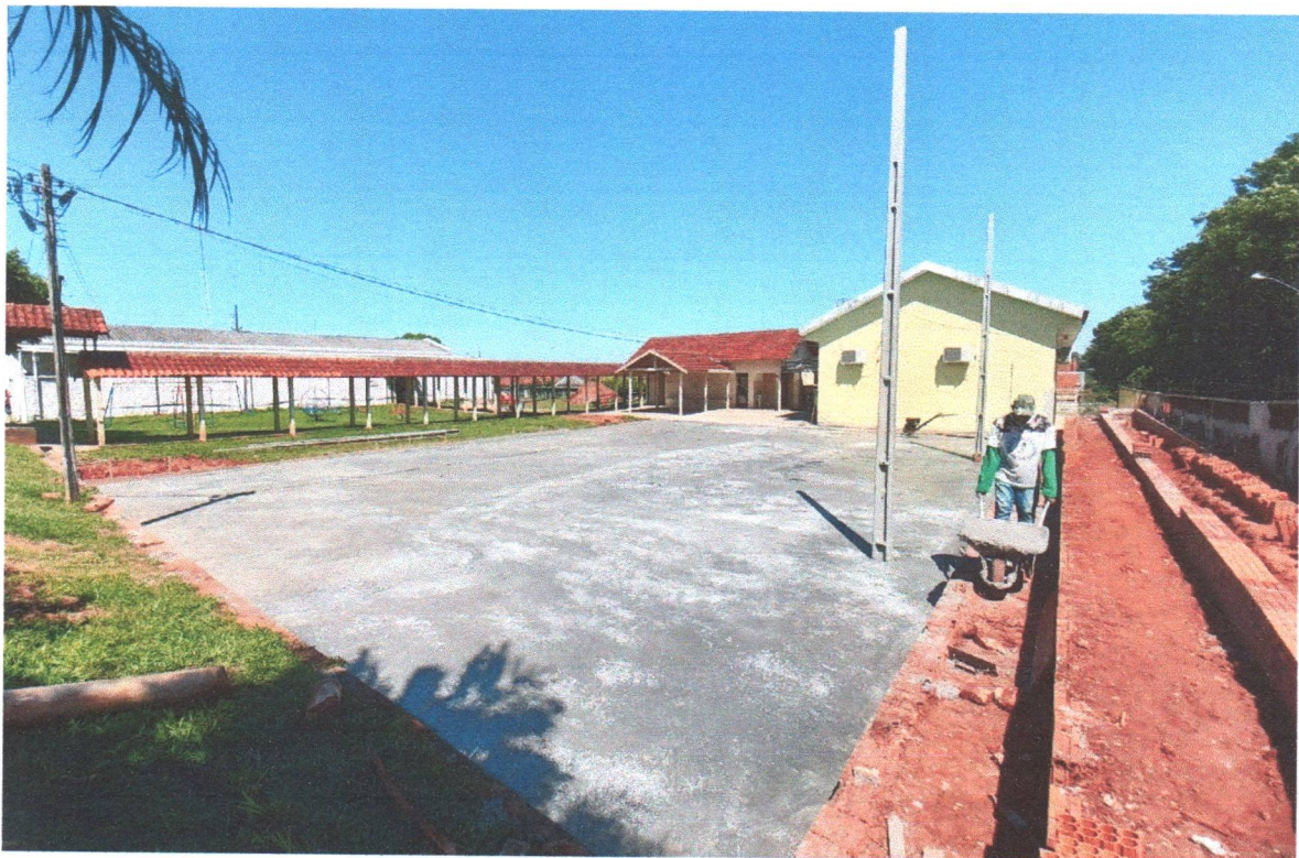
Foto 10: Construção da arquibancada em andamento
