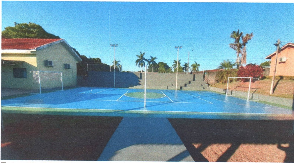
Fotos 28, 29 e 30: Construção da quadra finalizada
