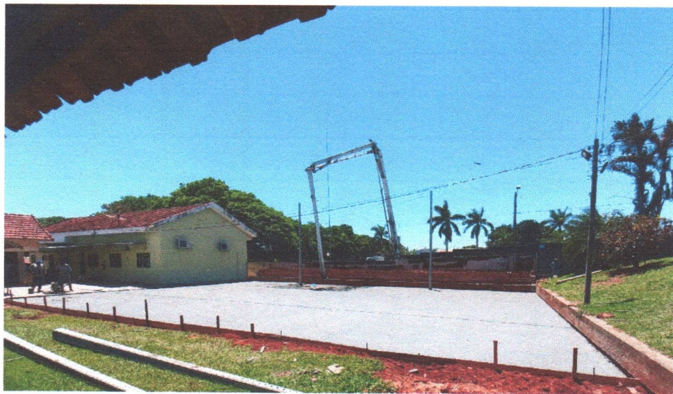
Fotos 6 e 7: Aplicação do concreto
