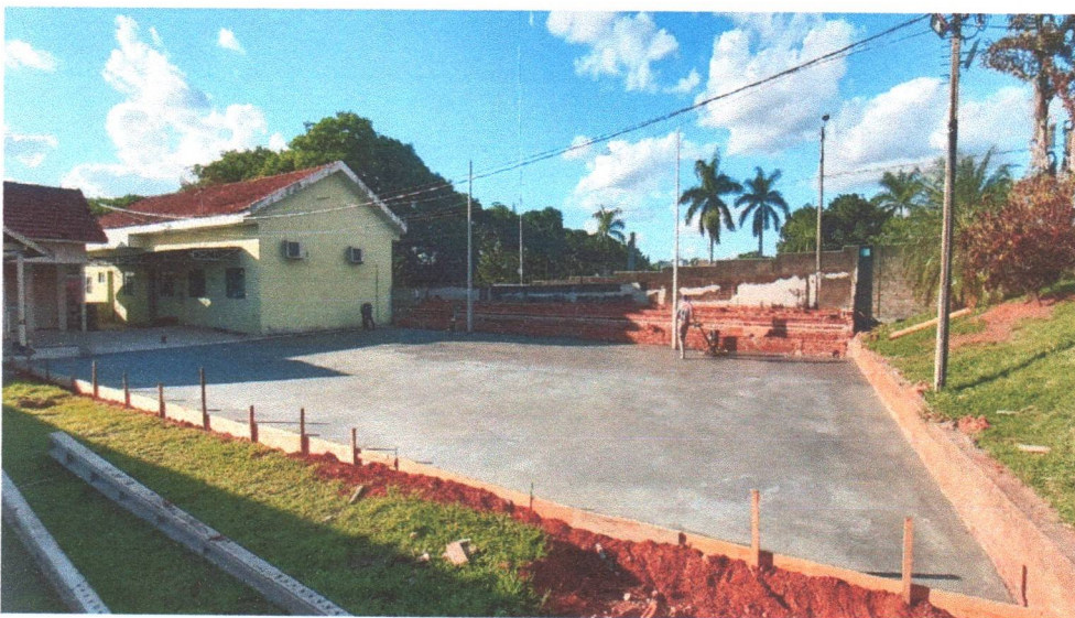
Foto 8: Polimento do concreto
