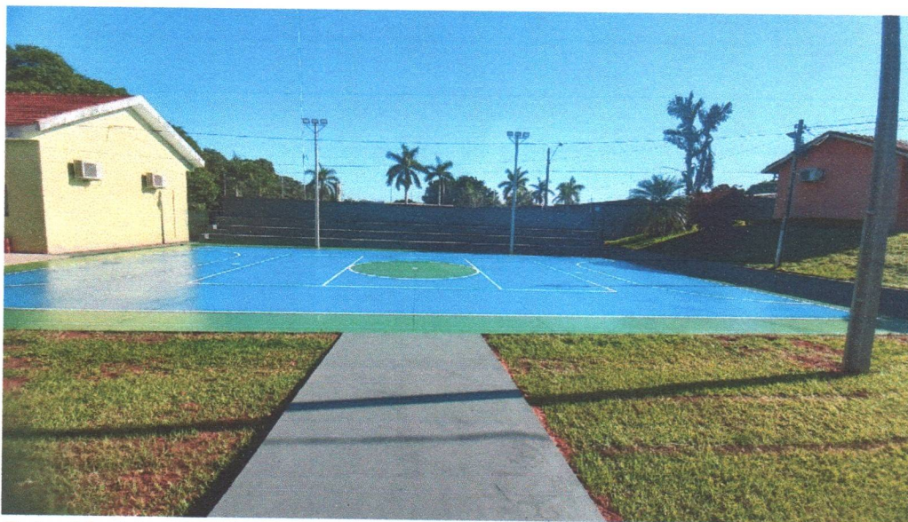
Foto 23, 24 e 25: Pintura finalizada
