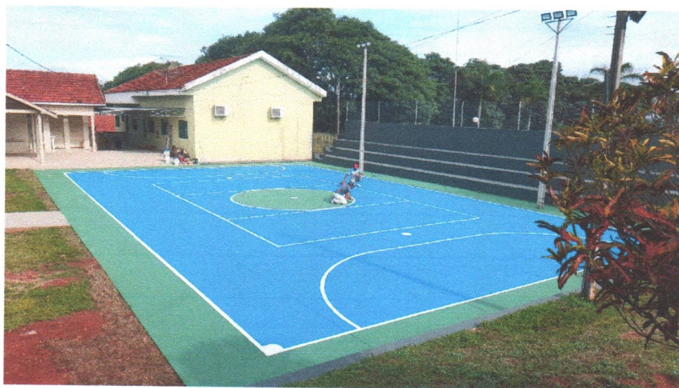
Fotos 21 e 22: Aplicação de tinta acrílica
