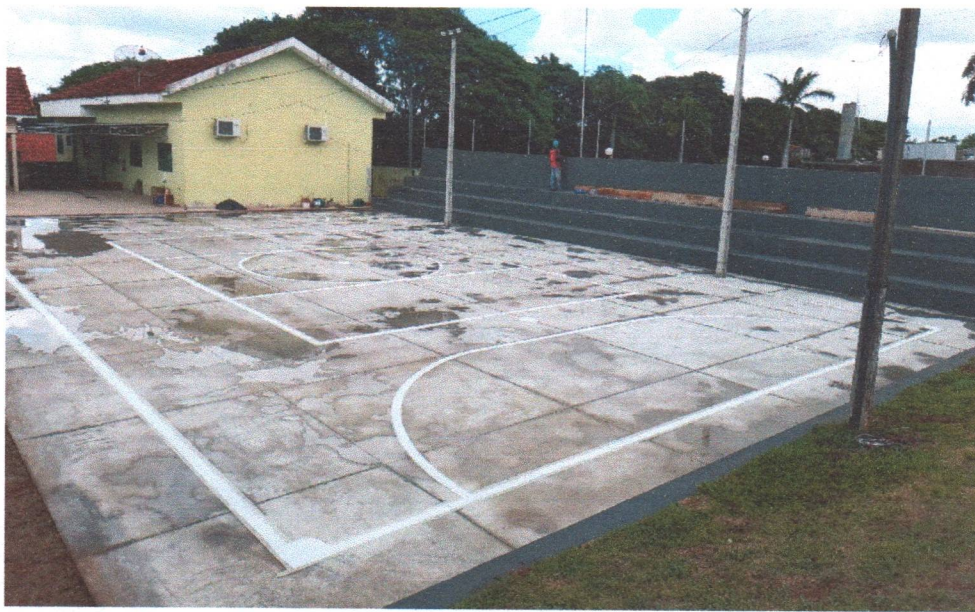
Foto 20: Marcação da quadra
