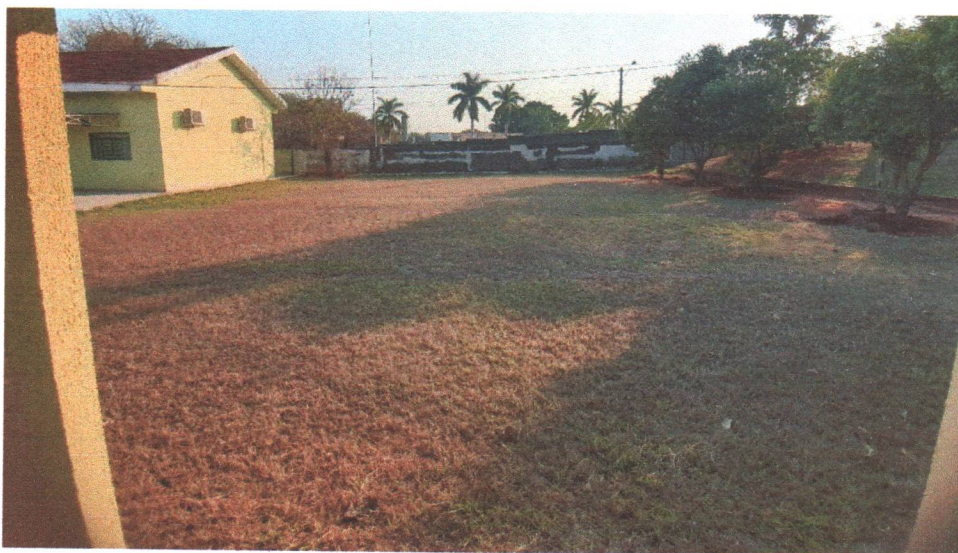
Foto 1: Espaço para construção da quadra antes do início da obra
