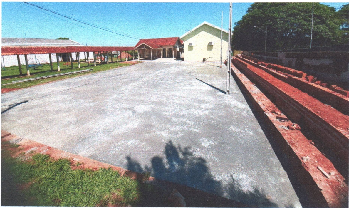
Foto 9: Aplicação do concreto finalizado
